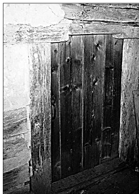
116. Вхідні двері житла. Фото автора.
