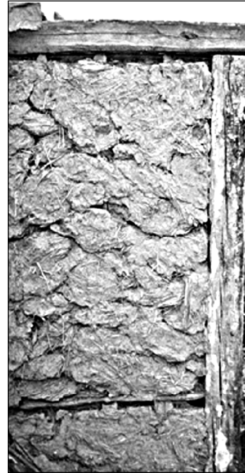
97. Конструкція риглевої стіни. Село Круті Кодимського району. Фото автора.
