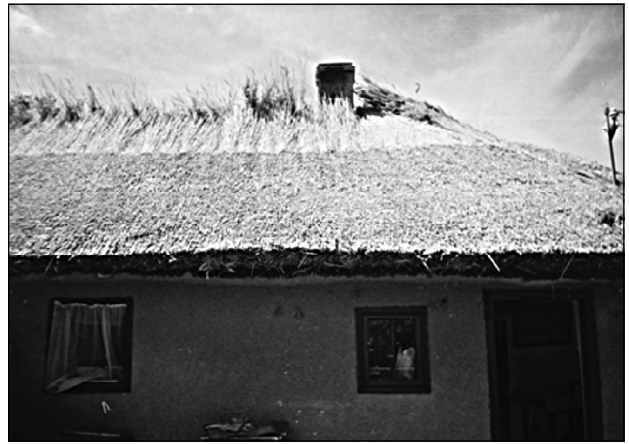
186. Вкриття будівлі способом "по - німецьки". Повіт Тульча. Фото автора.
