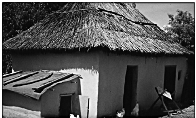
185. Вкриття будівлі способом "по - руськи". Повіт Тульча. Фото автора.
