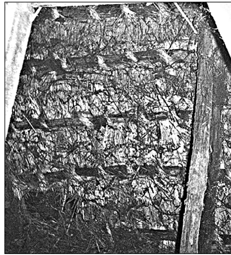
101. Техніка вкриття даху околотом. Село Перейма Балтського району. Фото автора.
